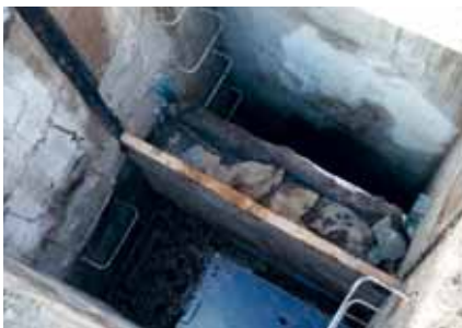
Ertüchtigung des Ablassbauwerkes Mühlteich Trebsen
