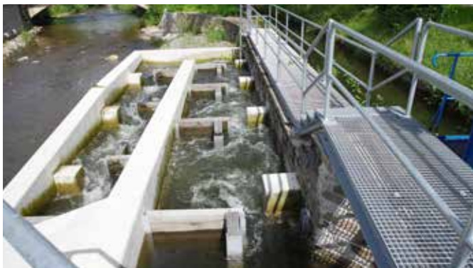
Abb. 2: Gesamtansicht der Fischaufstiegsanlage im Juni 2016
