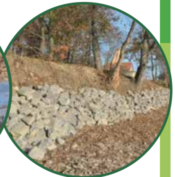
Ufersicherung mit Natursteinen
