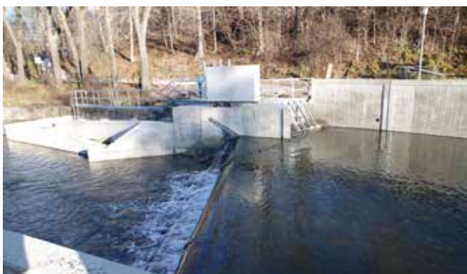
Abb. 4: Gesamtansicht Wehrneubau mit Fischaufstiegsanlage
