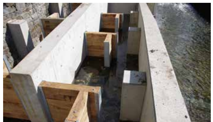
Abb. 5: Bauphase der FAA- Trennwände, Leitwände, Umlenklöcke
