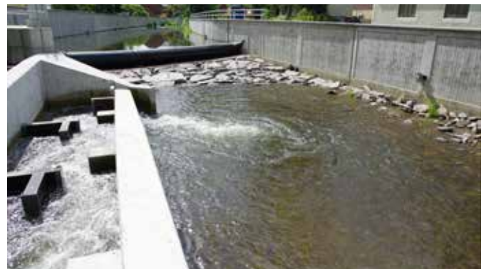
Abb. 3: Leitströmung aus der FAA nach Unterstrom
