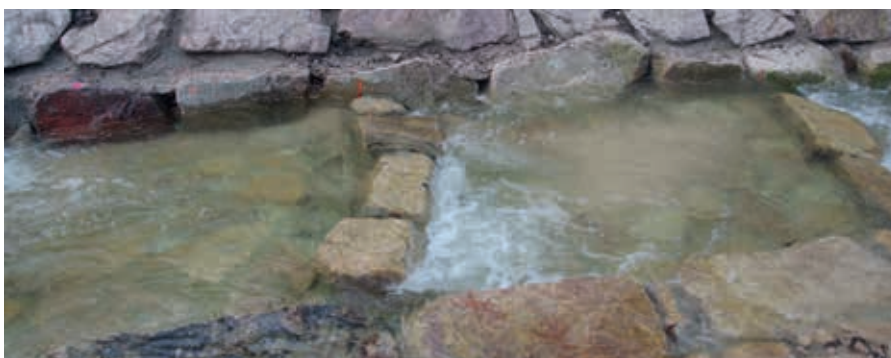
Teilansicht von Querriegel und Becken
