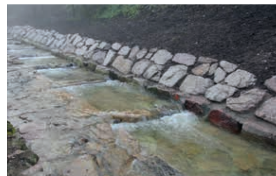
Raugerinne bei einem Abfluss von etwas über Q30 im Spätherbst 2016
